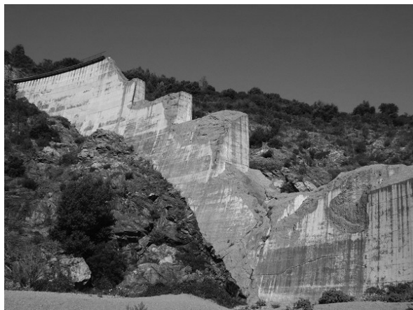
Figura 4: Foto della diga di Malpasset dopo il crollo.
