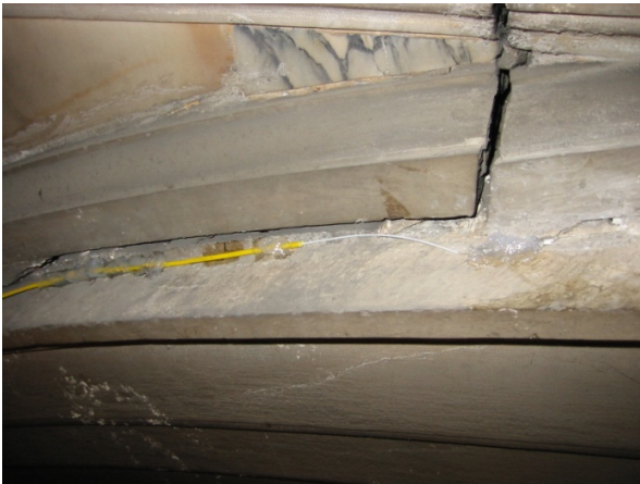
Figura 4: Sala del Tintoretto, Scuola Grand di San Rocco. Terminazione della dorsale SR1, lato sensore SR11.
